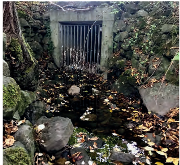
Abb.13: Einleitungsbereich aus einem Regenüberlaufbecken in den Mühlbach in Abschnitt C (Foto: A. Schwarzer).
