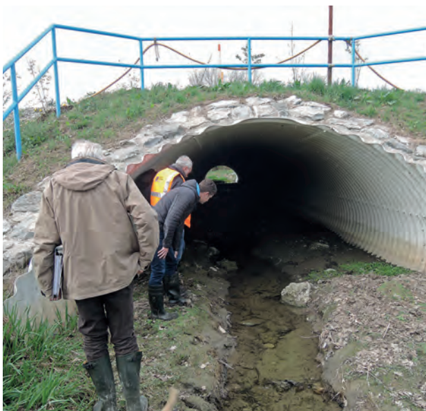
Abb 14 a und b: Der große Rohrdurchlass (Abschnitt B) von außen im Jahr 2017 sowie im Inneren bei der Bestandskontrolle im Jahr 2020 (Fotos: J. Trautner, A. Schwarzer).
