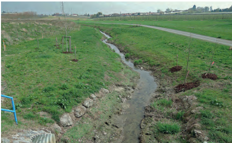
Abb. 4: Blick vom großen Rohrdurchlass auf den oberen Bereich des Abschnitts A rund 2,5 Jahre nach dessen Anschluss (April 2017, Foto: J. Trautner).
